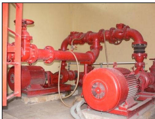
Gambar 2. Sistem pompa hidran kebakaran gedung reaktor RSG-GAS
