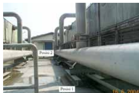
Gambar 3. Sistem Pendingin Sekunder
